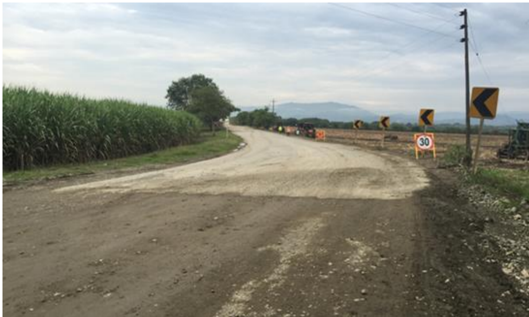
Fotografía 1. PR134+700. Se observa el límite de la vía (en afirmado).
