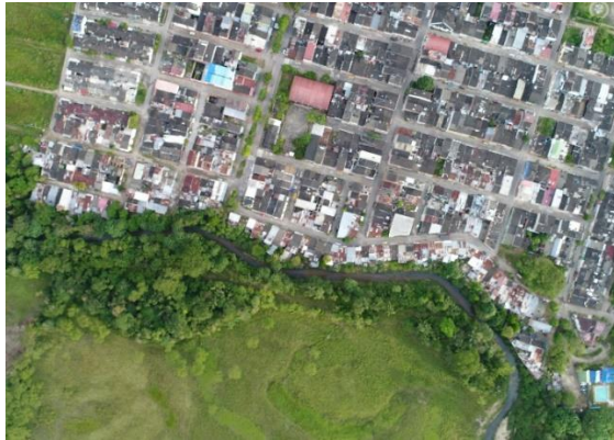
Ilustración 7. Vista aérea ronda hídrica y asentamientos
