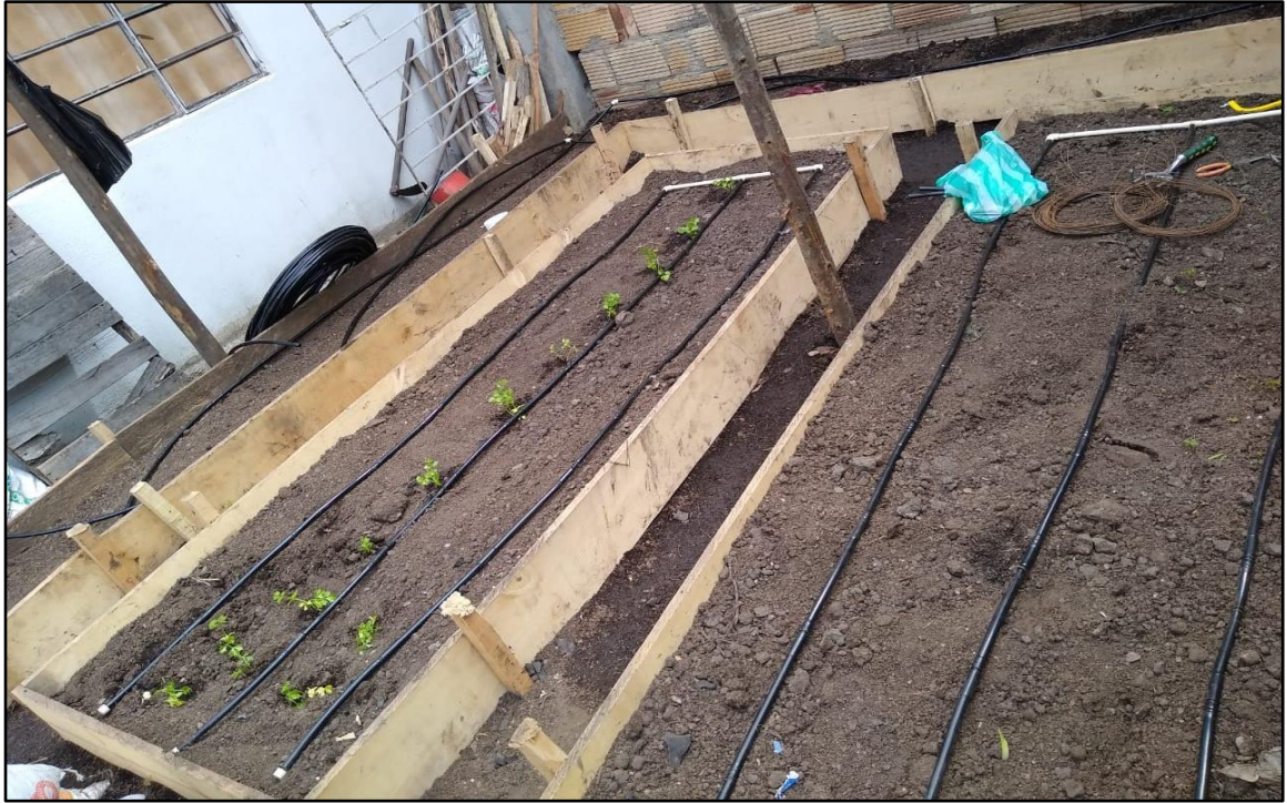
Figura 33 Instalación del sistema de riego
