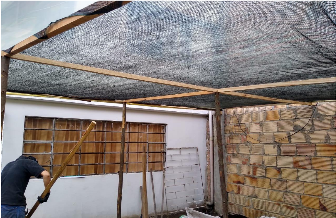
Figura 31 Instalación de techo y paredes del invernadero
