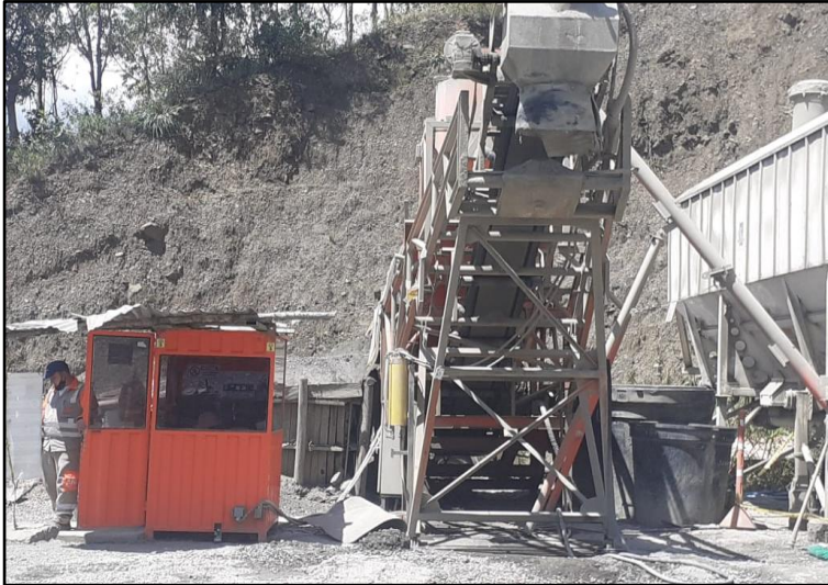
Figura 27. Estado de planta dosificadora con un año en servicio
