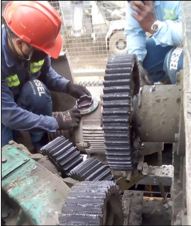
Figura 26. Intervención en reductor de mezclador
