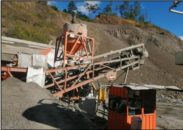
Figura 28. Estado de planta dosificadora con un año en servicio
