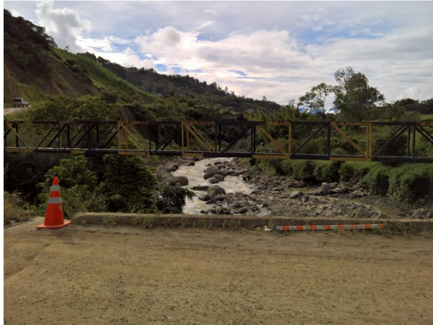
Figura 20. Fotografía vista aguas abajo
