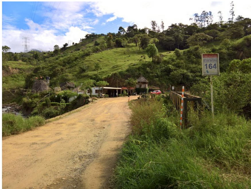
Figura 21. Fotografía vista superior tablero del puente
