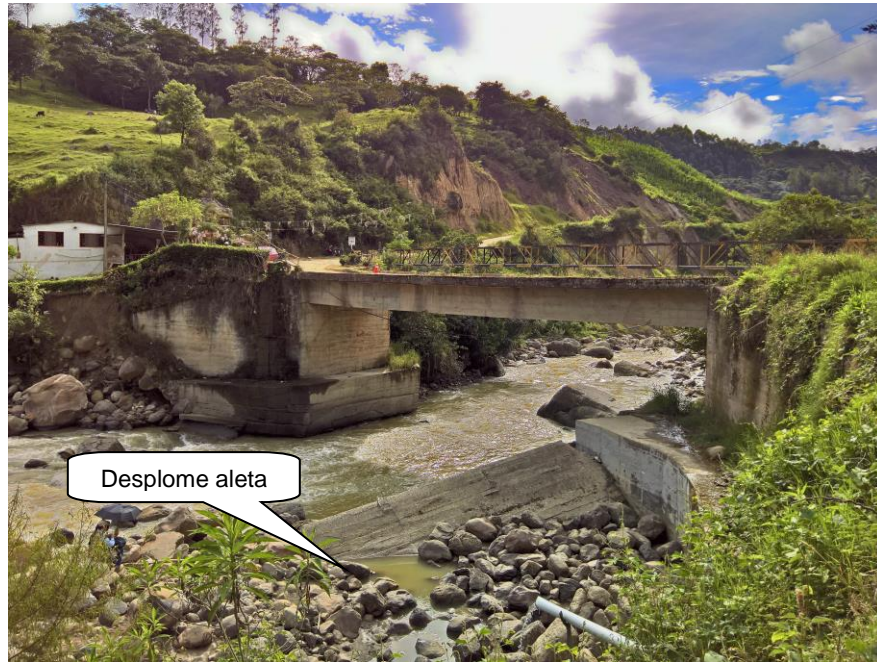
Figura 18. Fotografía sección puente (Aguas arriba)
