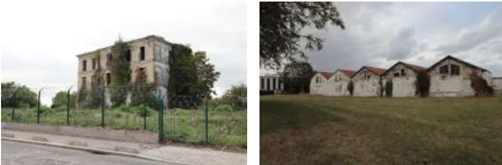
Figura 15. Registro fotográfico del estado actual de los edificios patrimoniales
