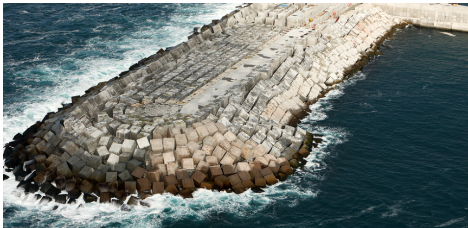
Figura 37 – Ilustração do quebra-mar norte, de tipologia mista, do Porto de Punta Langosteira , onde se pode observar a constituição do manto resistente deste, composto por blocos de betão cúbicos (Delft Hydraulics, 2004).
