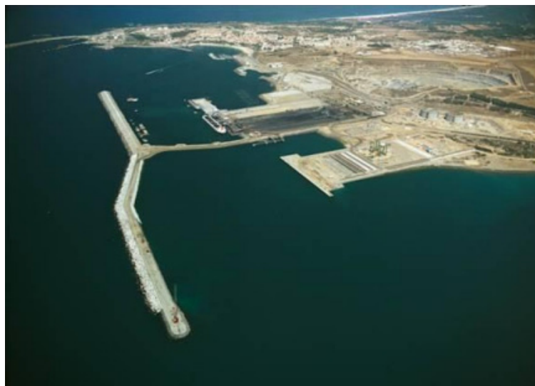
Figura 33 – Ilustração do Molhe Este do Porto de Sines, de tipologia em taludes, localizado na área do terminal de contentores (Teixeira, 2012).
