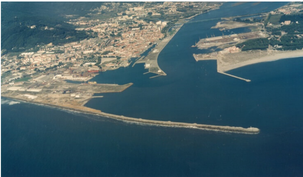
Figura 31 – Ilustração aérea do porto de Viana do Castelo, onde se pode visualizar o quebra-mar de taludes a norte, com 2 100 metros de extensão e que alberga esta infraestrutura portuária (LNEC, 2009).
