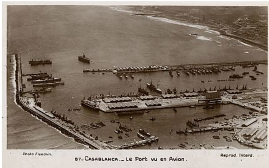
Figura 53 – Quebra-mar de Casablanca que serviu de base para o dimensionamento e implementação do quebra-mar submerso na sequência do desmoronamento do quebra-mar vertical norte (Fonte: Alamy, 2019).
