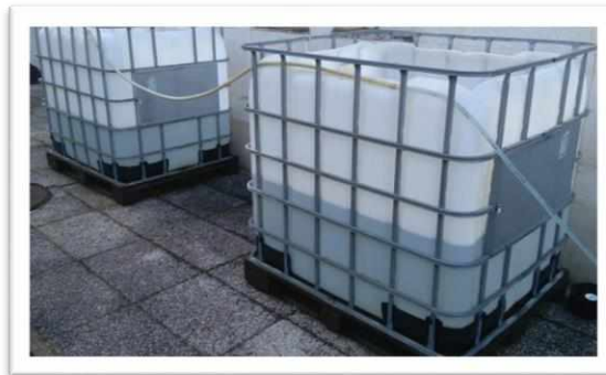
Figura 16- Reservatórios da instalação piloto.
