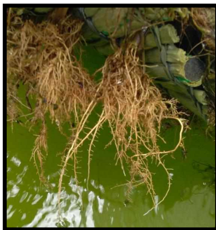
Figura 23- Verificação do estado de degradação da jangada flutuante.
