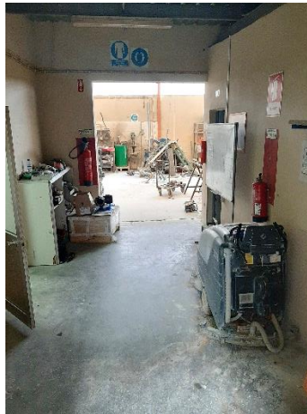
Figura 13 - Falta de marcação do chão
