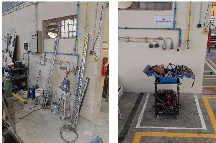
Figura 39 - [A] Área onde estavam calhas para passagem de fios elétricos (Antes); [B] Área do carro ferramenta (Depois)
