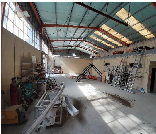
Figura 30 - Oficina de Manutenção após classificação e separação
