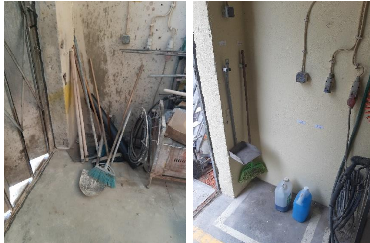
Figura 49 - [A] Área de material de limpeza (Antes); [B] Área de material de limpeza (Depois)
