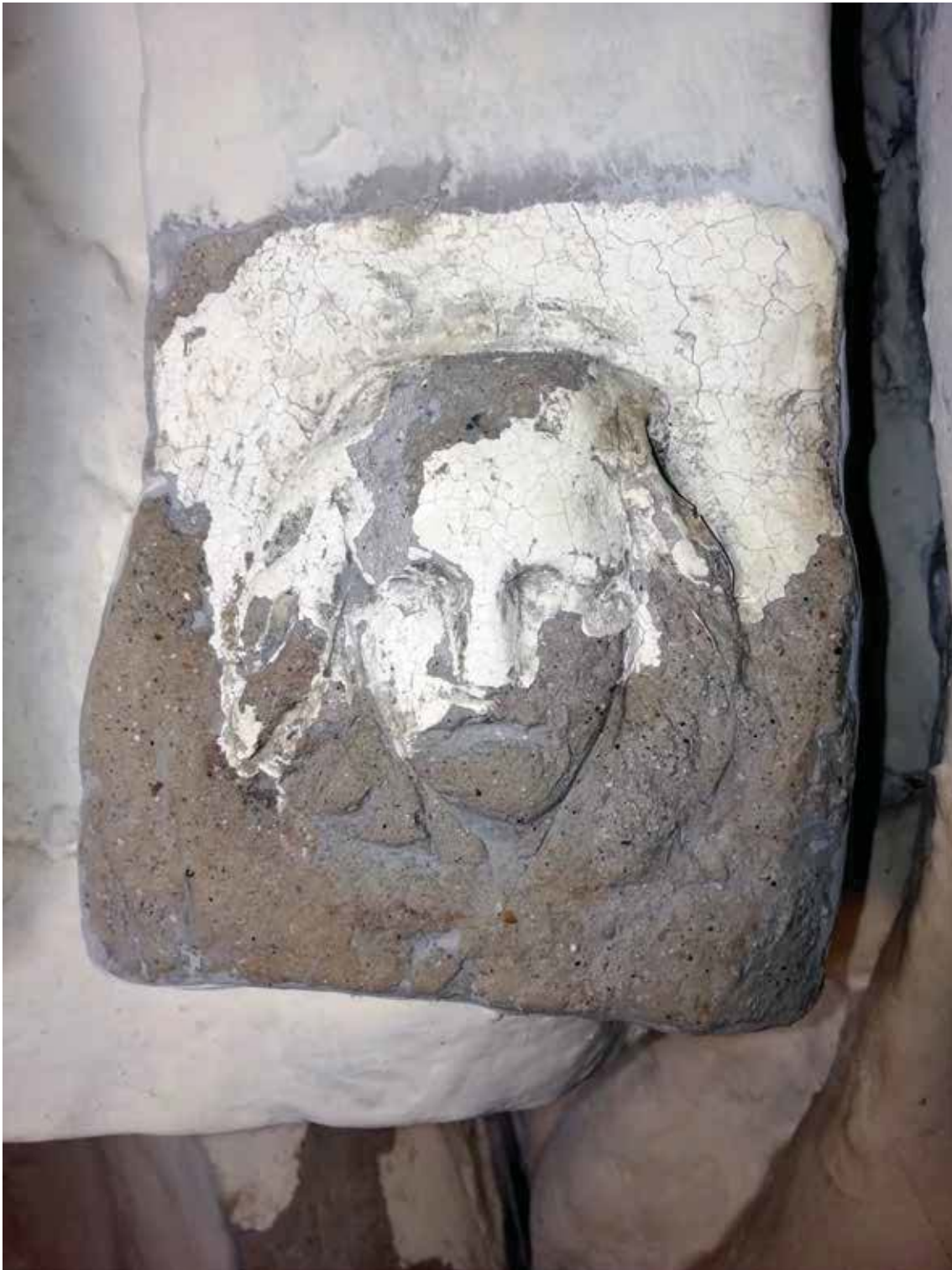
Fig. 5.-Detalle del estrato de stucco illustrato original en la tribu Gad, descubierto tras la cata de limpieza. (Fotografía: de los autores).
