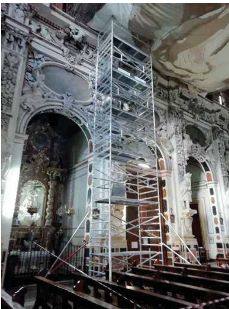
Fig. 2.- Torre de andamio instalada en la nave central para la realización de los estudios previos. (Fotografía: de los autores).
