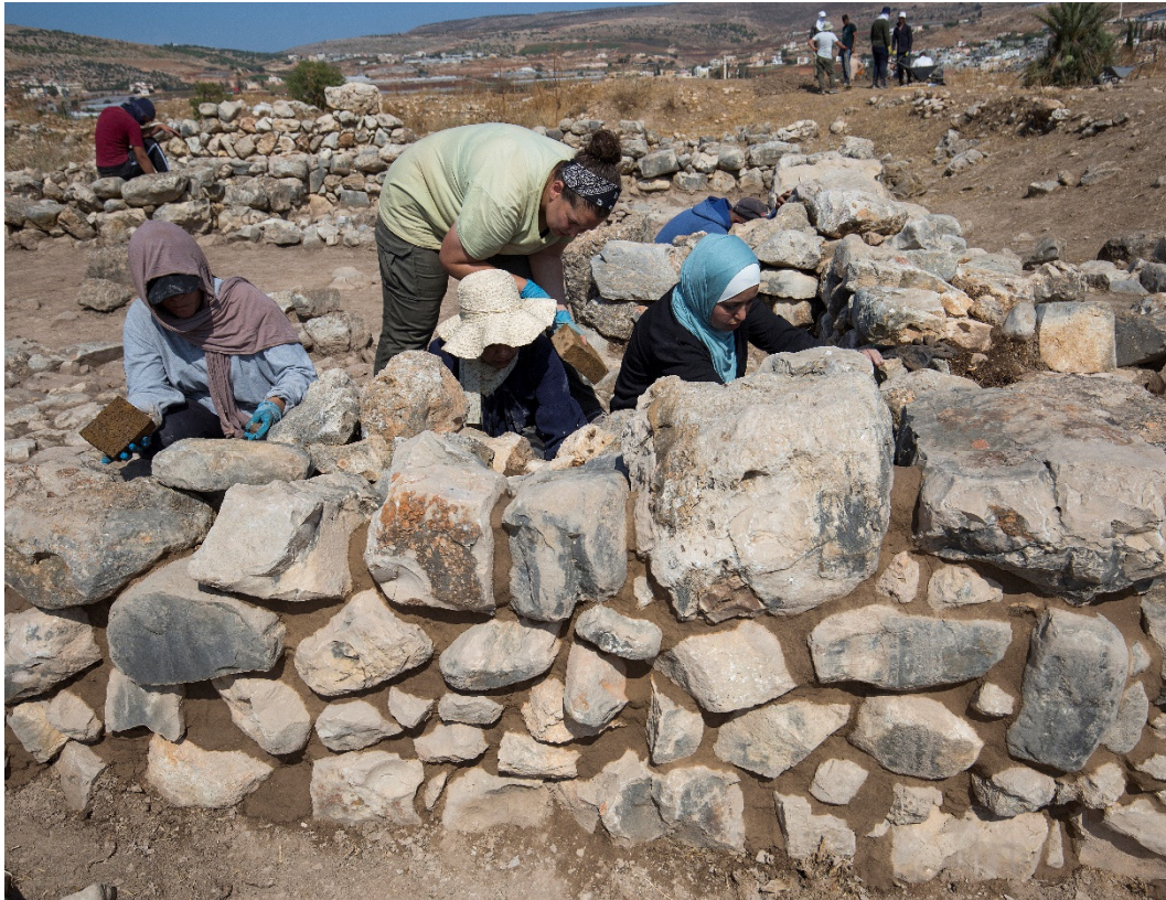
Fig. 11. Detalle de la técnica de restauración de un muro de la casa 327 (© TEF, José Pardo).
