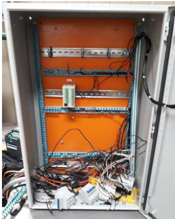
Figura 13. Desinstalación de dispositivos
