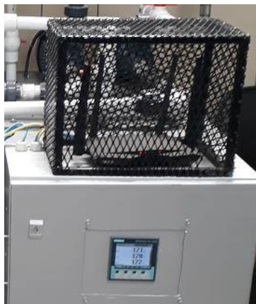
Figura 16. Estructura de Acces Point.
