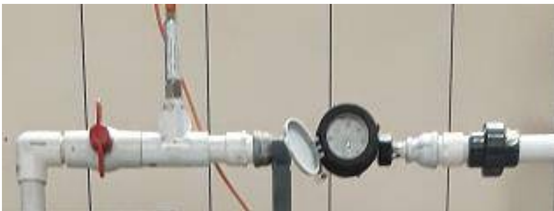
Figura 15. Calibración de sensor de presión
