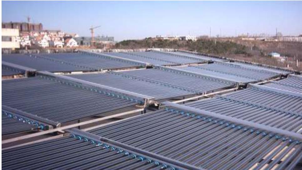
**Figura 38** Sistema de colectores con tubos de vacío tipo mariposa. [63]
