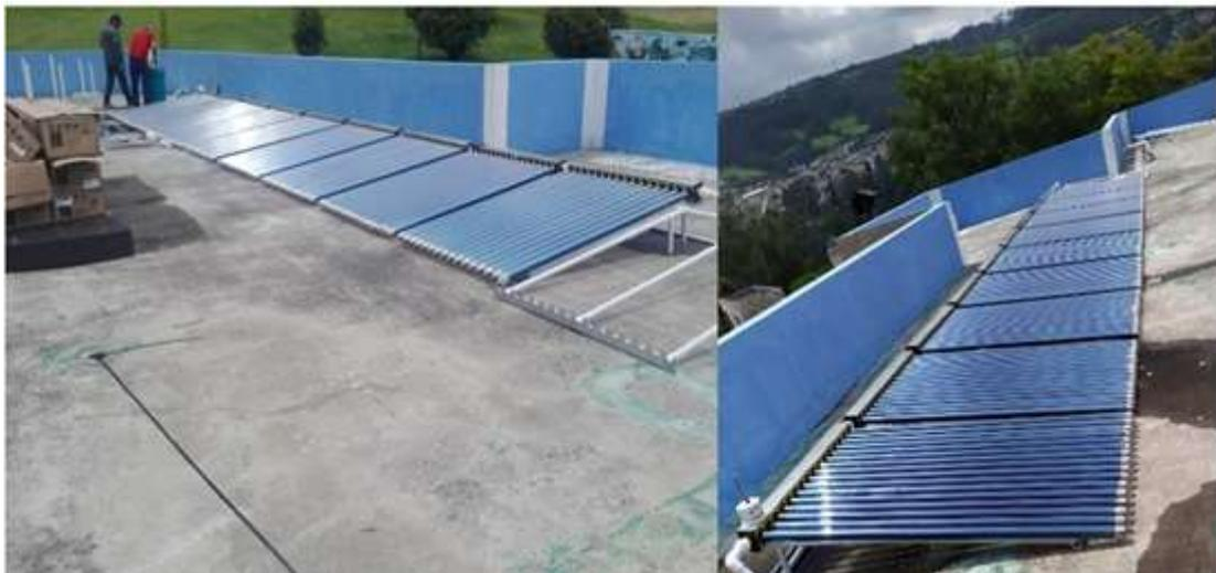
**Figura 36.** Montaje para la demostración del funcionamiento de los equipos. Cortesía DISTEC
