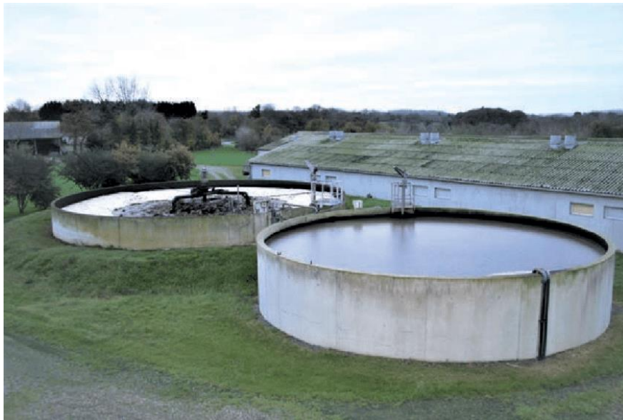
Imagen 1.4. Sistema de Nitrificación-Desnitrificación
