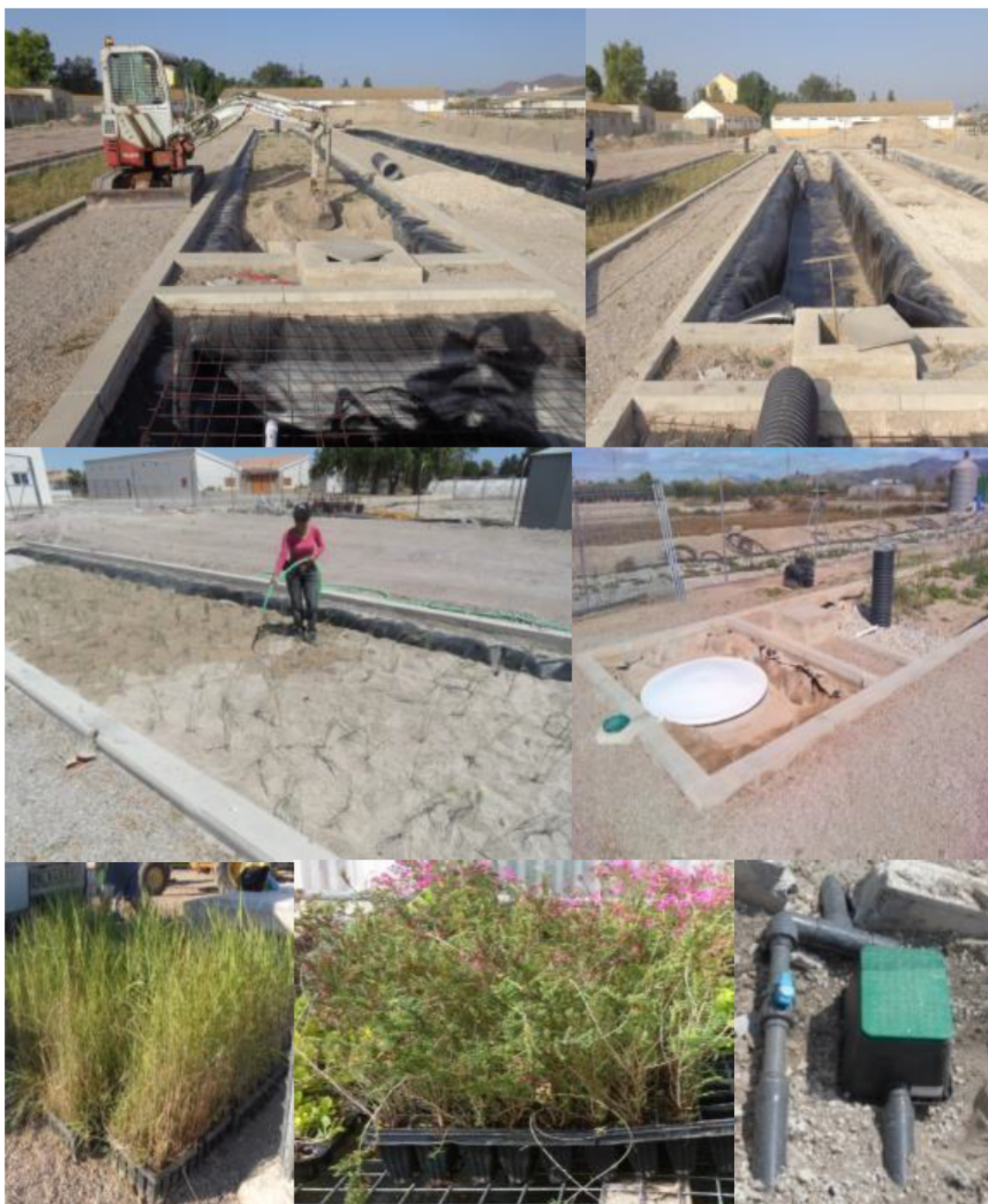
Foto 8.14. Acondicionamiento celdas del humedal y plantación policultivo.
