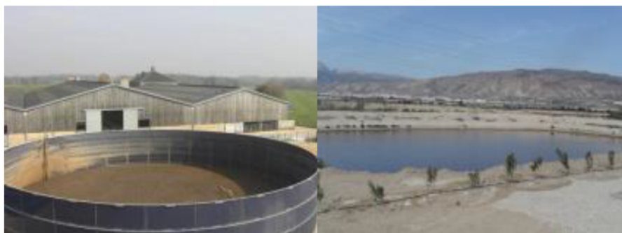
Imagen 1.2. Almacenamiento de purines.
