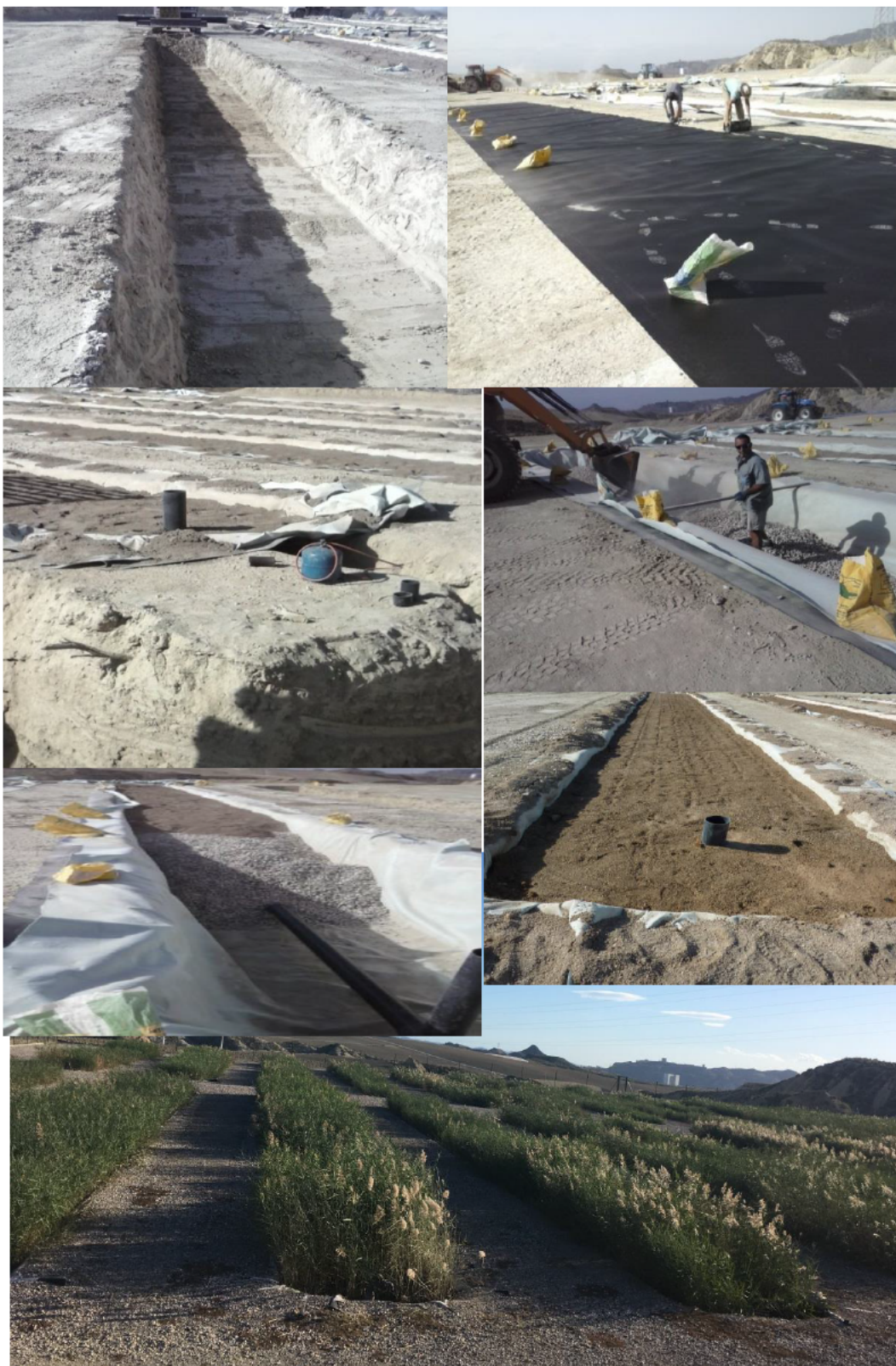
Foto 8.17. Construcción biofiltros proyecto a escala real.
