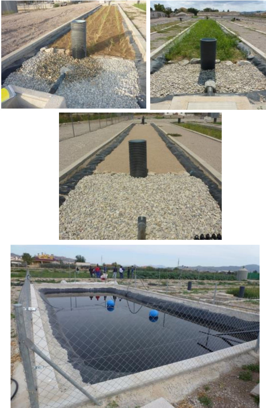
Foto 8.15. Humedal y balsa de almacenamiento ensayo piloto.
