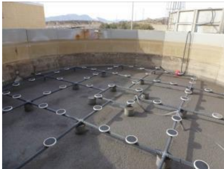
Imagen 5.5. Membranas de aireación en la base del depósito B2.
