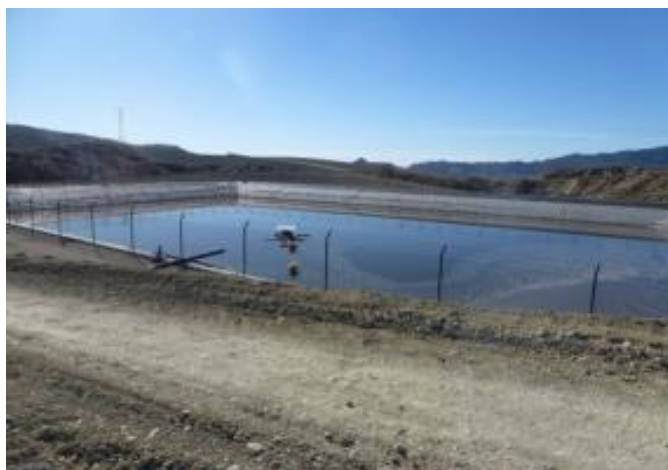
Imagen 5.8. Balsa de almacenamiento del purín depurado.
