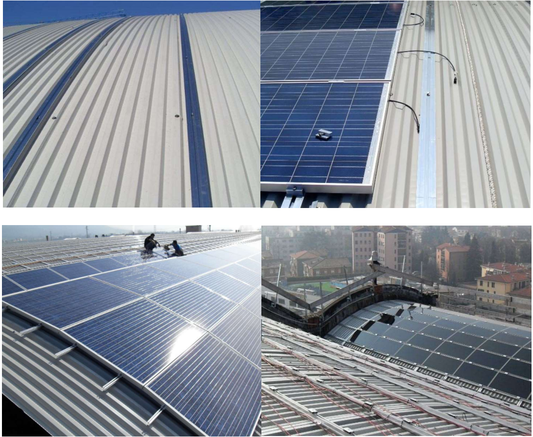
Ilustración 85- Instalación cortesía de ALUBEL
