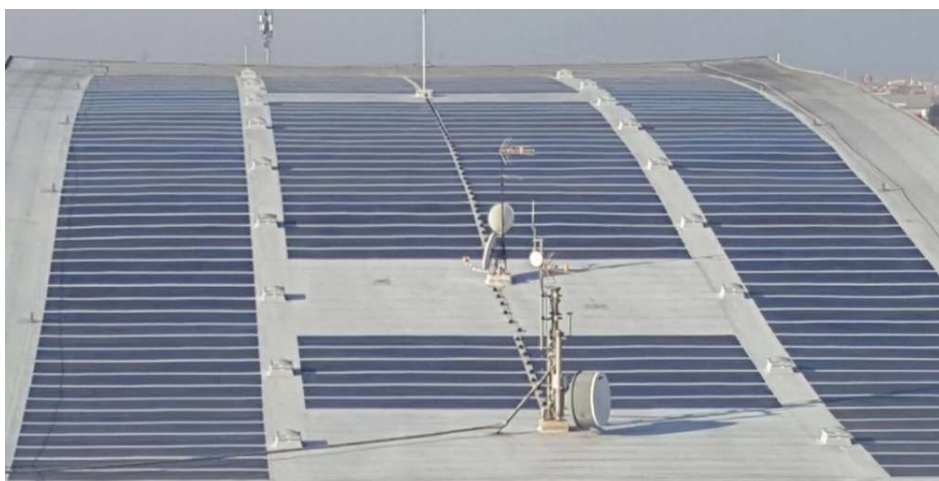
Ilustración 68- Instalación paneles flexibles ALWITRA cortesía de KOLTER
