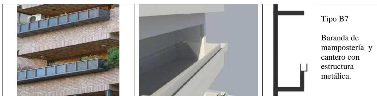
Figura 7: Balcón tipo B7 – baranda de Mampostería y cantero
