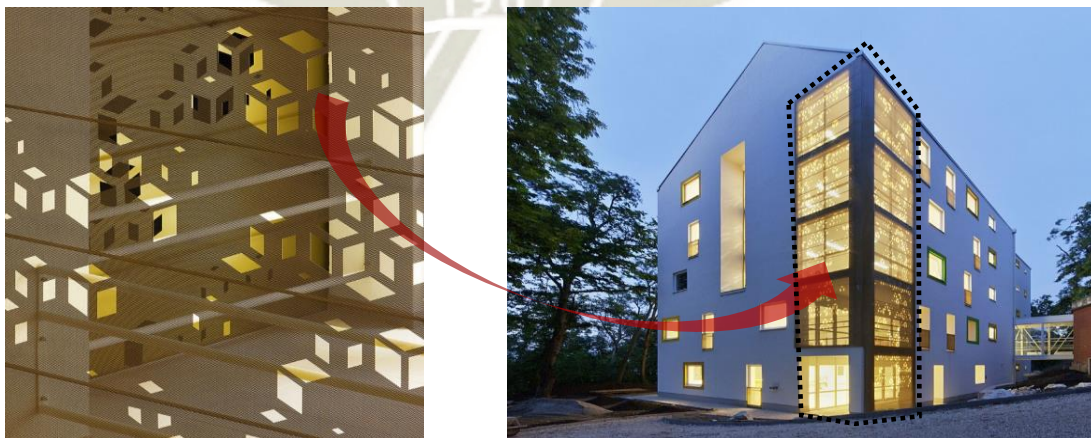
Gráfico 38. Imagen de perforaciones en la fachada del Instituto para ciegos Batthyany Laszlo. Fuente propia.
