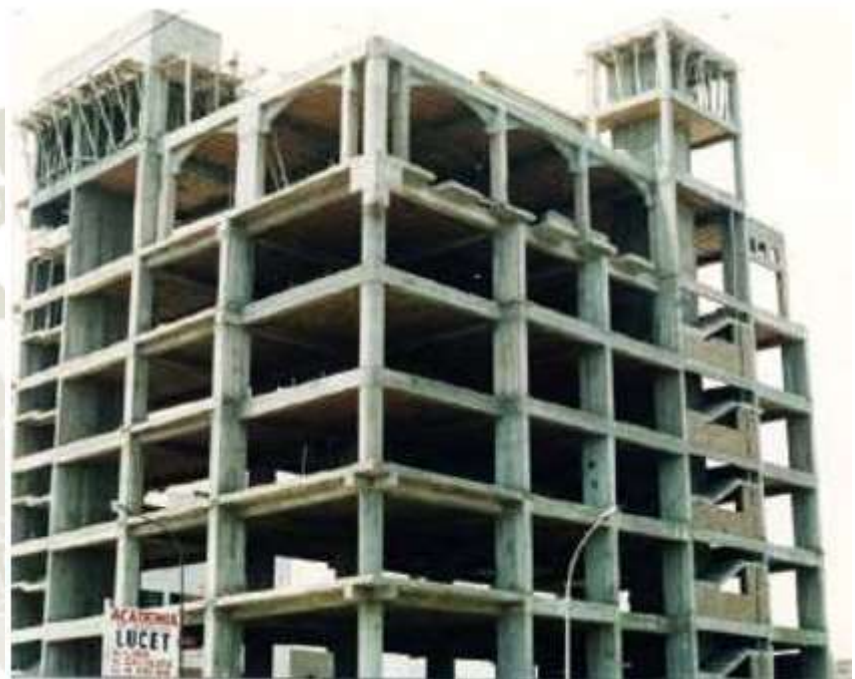
Figura 1 Sistema Estructural de Pórticos (A. Hurtado, 2014)
