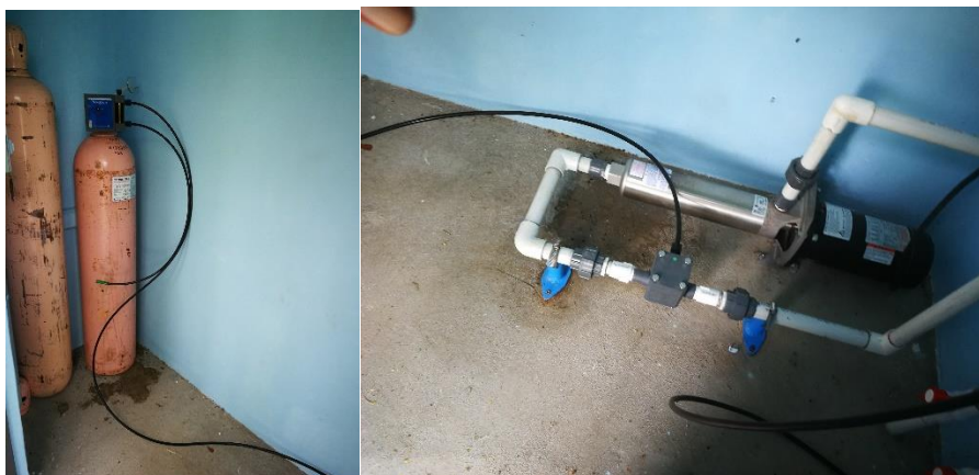
Figura 16. Cloración con Gas hipoclorito el Roble Puntarenas. Fuente: Elaboración propia.
