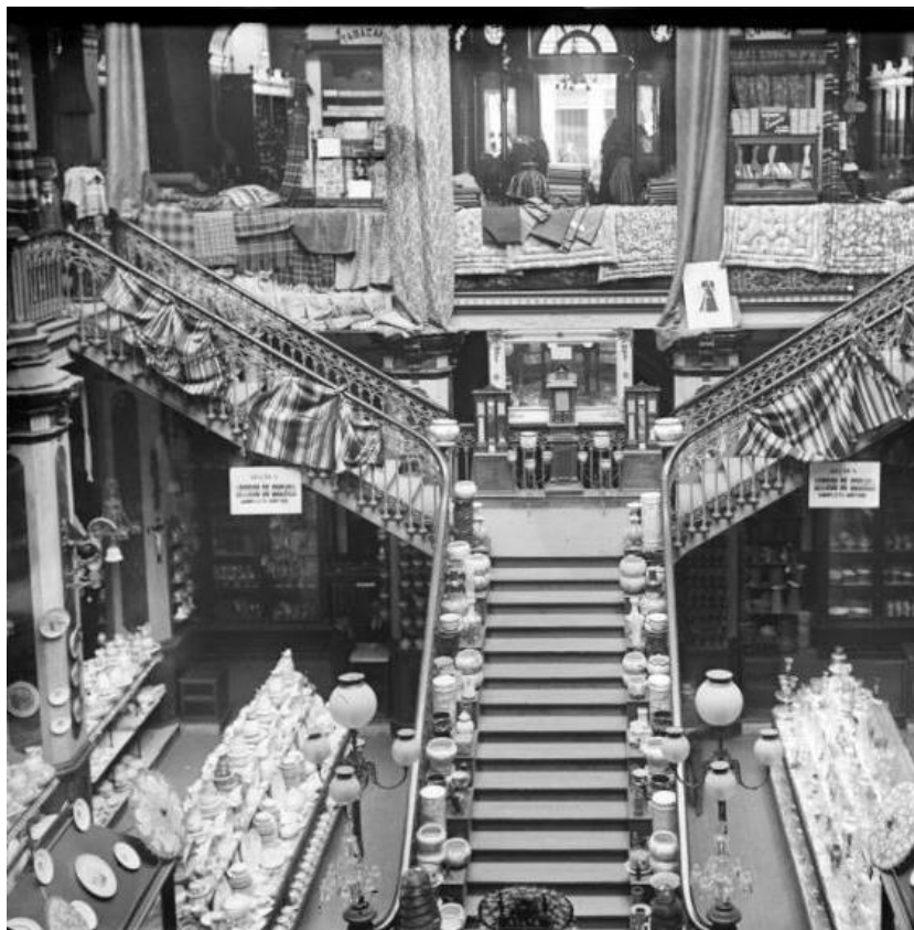
Figura 15 – Foto dos interiores dos Armazéns Hermínios 18
