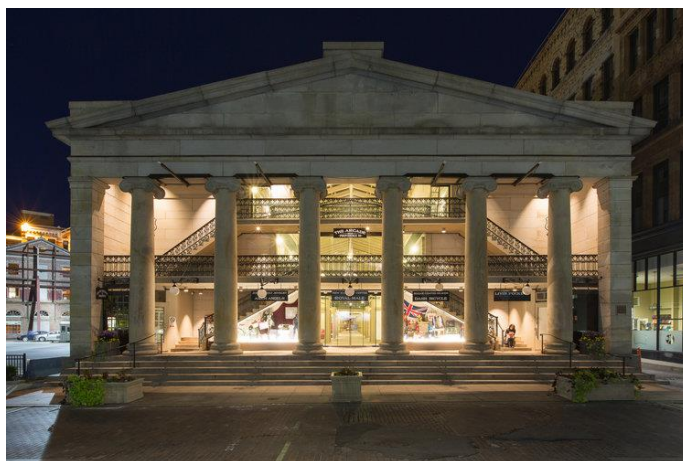
Figura 124 – Fachada Original de cerca de 1850 nos dias de hoje 41
