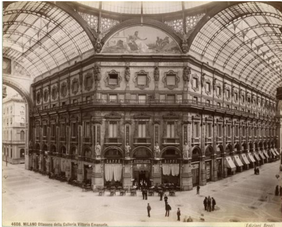
Figura 146 - Imagem do interior da Galleria Original. 60
