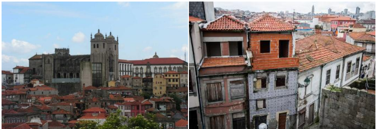
Figure 15 – a) View of the cathedral hilltop (“ Morro da sé”) ( http://imobiliario.publico.pt/Noticia/Detalhe/morro-da-se-perde-hotel-1773987 ); b) Rua de São Sebastião ( http://www.porto24.pt/cidade/obras-em-30-edificios-na-se-a-espera-de-parecer-decisivo-de-bruxelas ).
