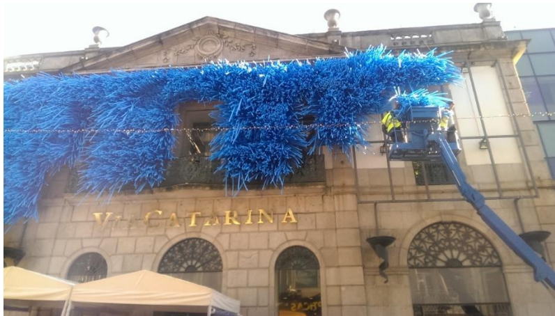
Figura 31 – colocação das peças contruídas para instalar o We(a)ving.
