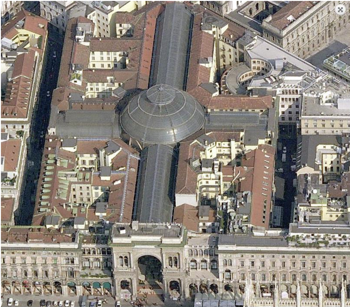
Figura 144 – Vista aérea atual das Gallerias V. Emanuele em Milão 58
