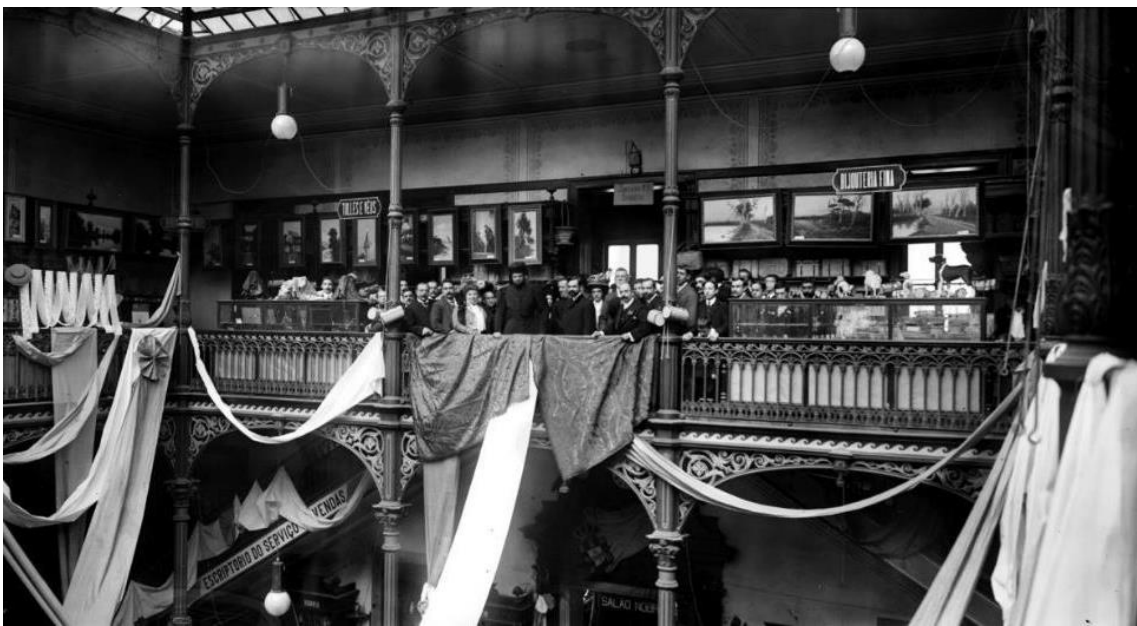
Figura 13 e 14 – Fotos dos interiores dos Armazéns Hermínios 17
