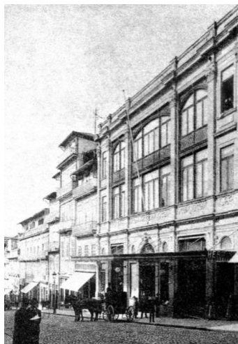
Figura 34 -Fachada da R. de Santo António (atual R. de 31 de janeiro) 32
