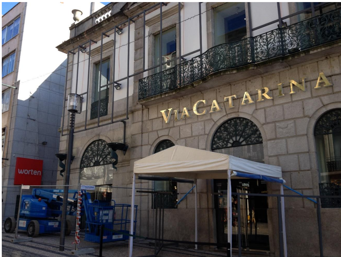
Figura nº 23- A fachada do centro comercial preparada para receber os participantes na criação da obra. Foto da autora.
