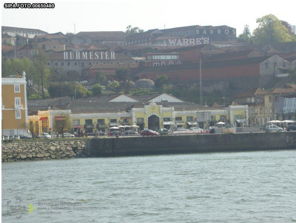
Figura nº 102 – Mercado da Beira Rio, Vila Nova de Gaia 99
