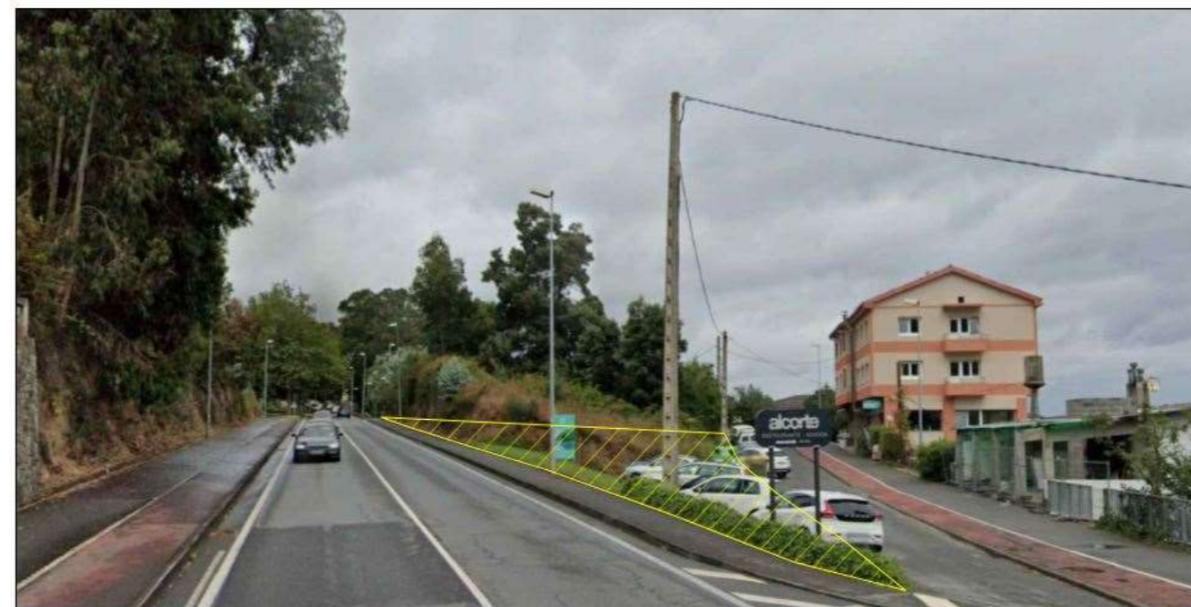
Vista desde el actual paso de peatones del futuro emplazamiento del aparcamiento "B"
