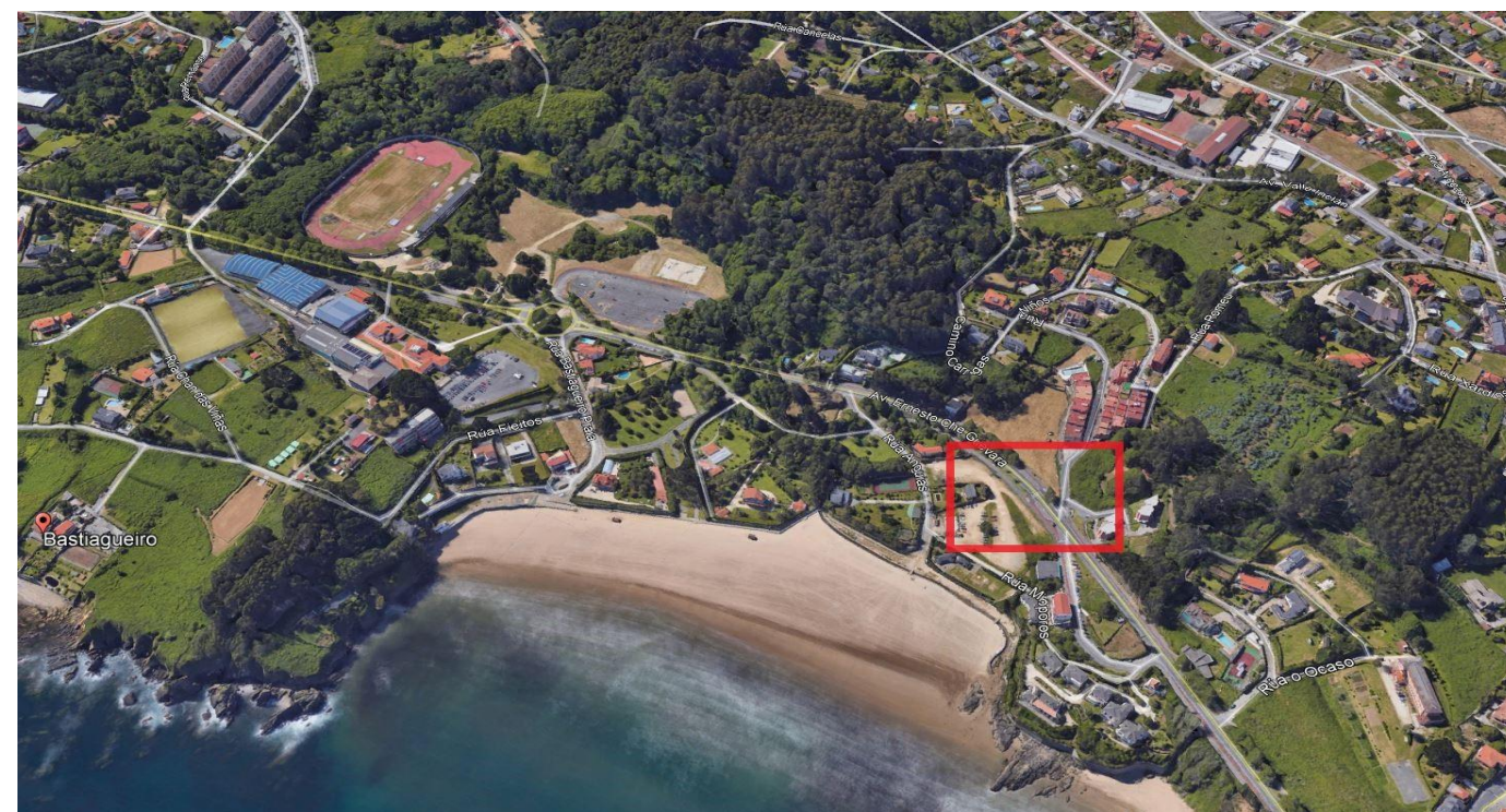
Detalle de la zona de actuación (Paso de Peatones de la AC-173)
