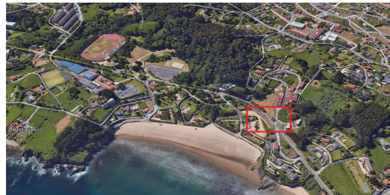
Detalle de la zona de actuación (Paso de Peatones de la AC-173)
