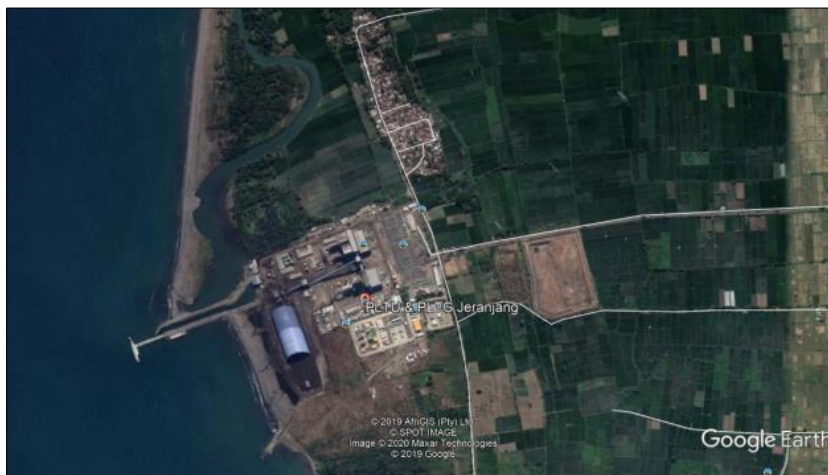
Gambar 1. Lokasi PLTU Jeranjang, Dusun Jeranjang, Lombok Barat, NTB
