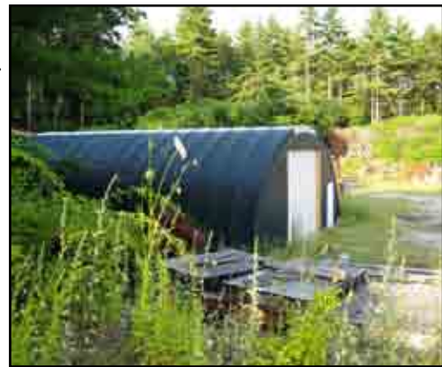
ORDE SITE MAINTENANCE SHED
