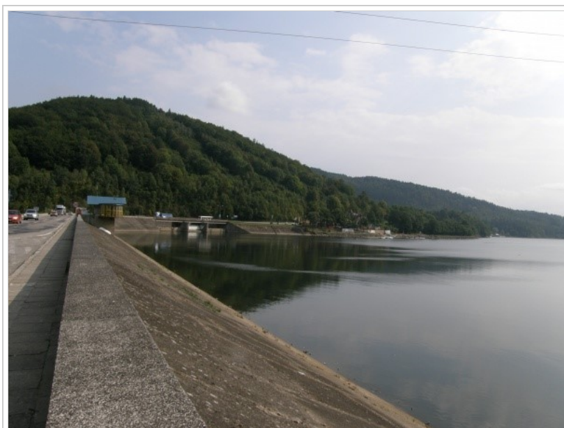
Fot. 3. Odwodna strona zapory zbiornika Tresna (fot. M. Rzętała)
