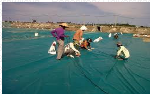
Gambar 7. Proses Perbaikan Plastik HDPE pada Tambak (Sumber : Data Lapang, 2019)
