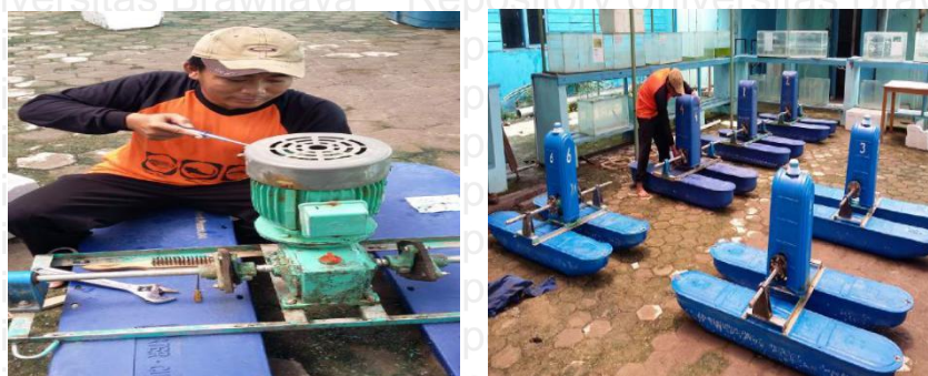
Gambar 11. Proses Pemasangan Kincir Air (Sumber : Data Lapang, 2019)
