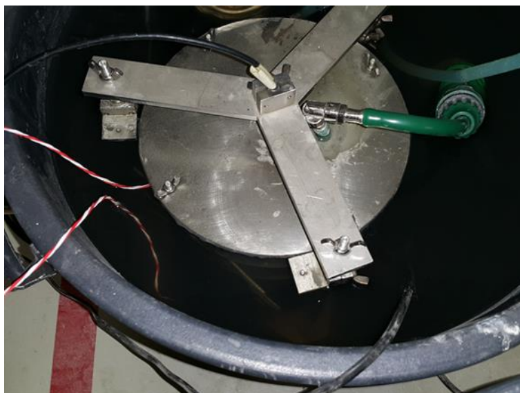
Figura 3 – Pormenor da ligação do tubo em espiral com a bomba.
