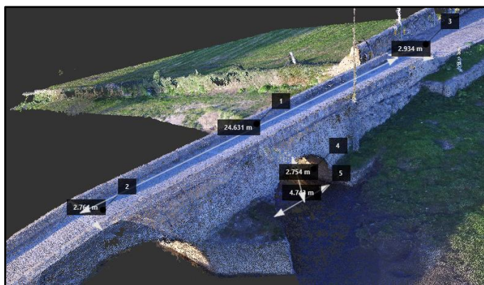
Figura 62-Medidas realizadas na nuvem de pontos da ponte medieval em Arcos
