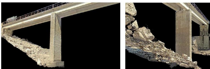
Figura 41-Perspetivas da nuvem de pontos da Ponte do Saltadouro em software RECAP
