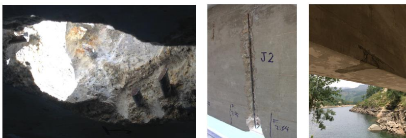
Figura 39 - Janelas de inspeção: J1, J2, J3
