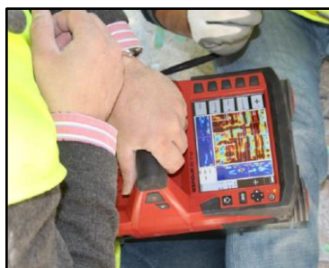
Figura 36-Equipamento para deteção de armaduras - Hilti PS1000
