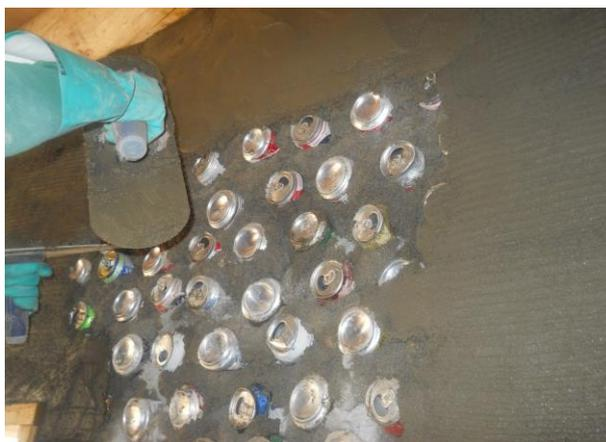
**Figura 2.16:** Parede interior de latas em construção (Earthship Biotechnology Portugal 2017)
