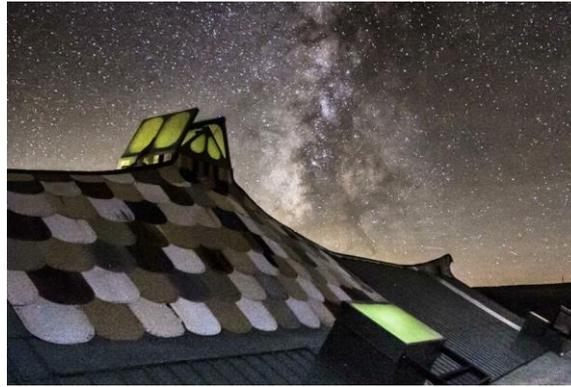
**Figura 2.24:** Cobertura de edifício Earthship onde é possível distinguir dois tipos de revestimento: chapa lacada e chapas provenientes do fim de vida de eletrodomésticos (Audrey Wright 2014)
