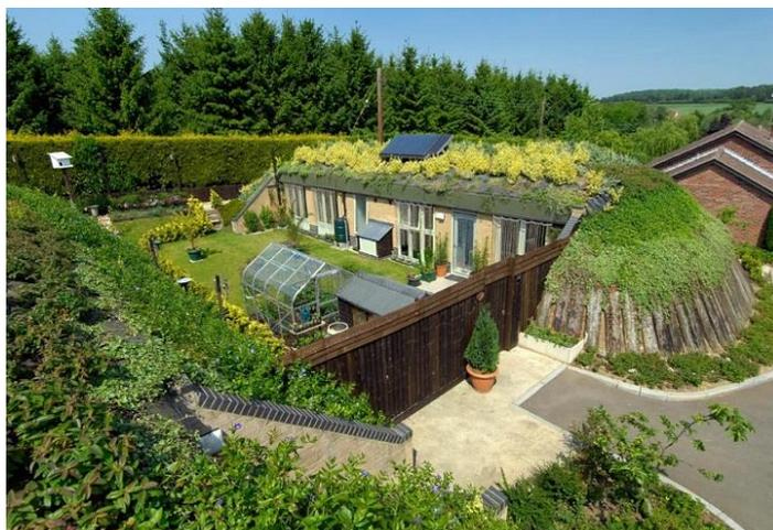
**Figura 2.4:** Construção *Earth Bermed* (outside table plans free 2014)
