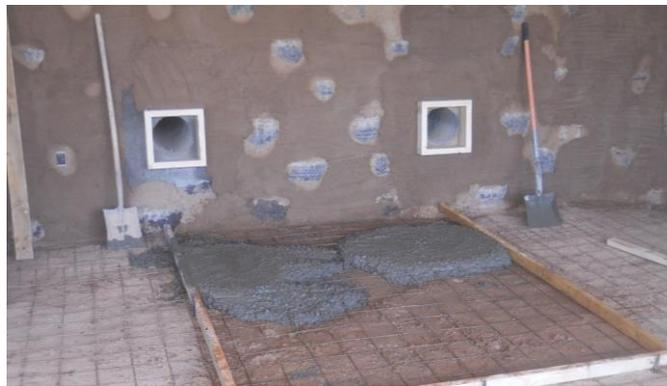
**Figura 2.8:** *Parede exterior sem revestimento onde é possível ver os tubos de ventilação inseridos (Earthship Bioteecture Portugal 2017)*
