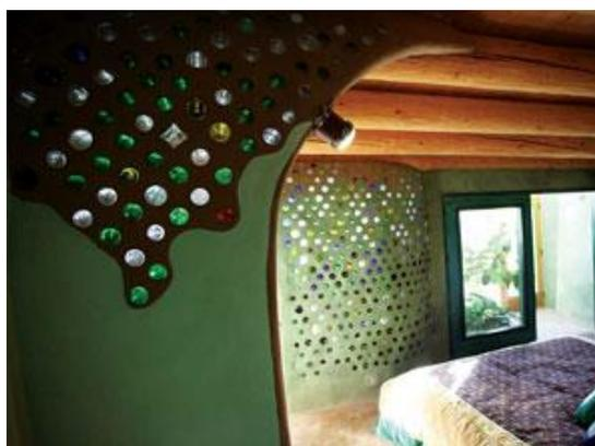
**Figura 2.20:** Divisão em que se verificam paredes parcial (à esquerda, em primeiro plano) e totalmente (à direita, em segundo plano) constituídas por garrafas e vidro, respetivamente (Bryan Welch 2009)
