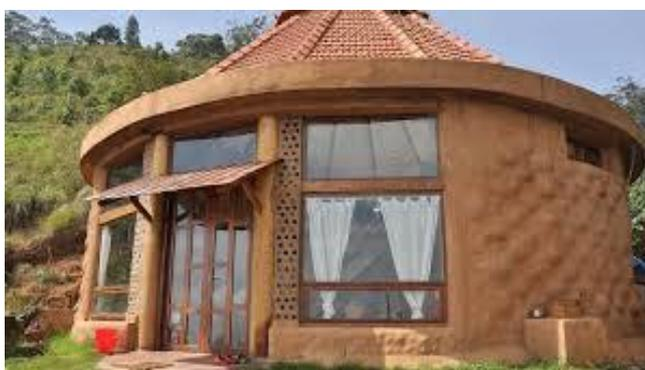
*Figura 2.15: Aspeto de uma parede exterior com as ondulações dos pneus visíveis (Karuna Farm 2014)*
