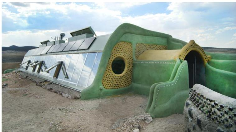
**Figura 2.2:** Habitação Earthship com grandes envidraçados inclinados orientados a sul e de arquitetura incomum (Chelnys 2015)
