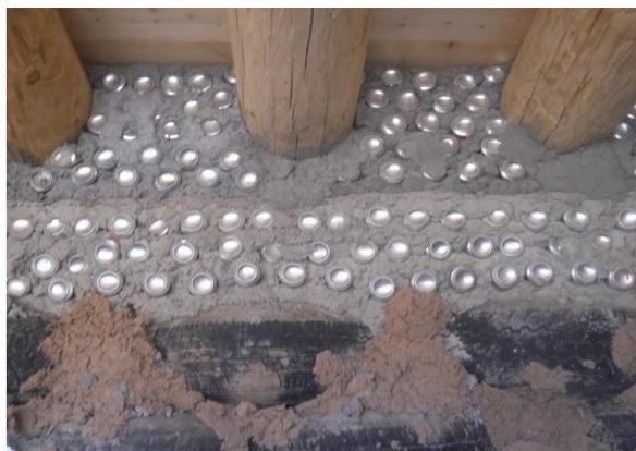
**Figura 2.13:** Pormenor construtivo das juntas entre o topo das paredes e a cobertura (Earthship Biotecture Portugal 2017)
