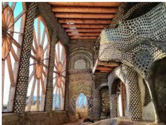
**Figura 2.17:** *Superfícies interiores inacabadas que apresentam o aspeto de um acabamento de parede interior com as latas visíveis (Earthship Biotecture 2017j)*
