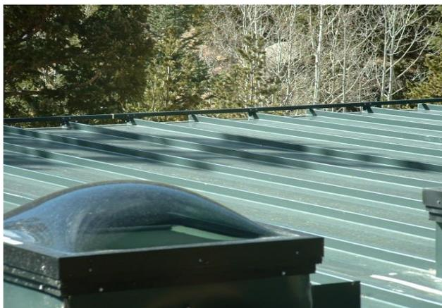
**Figura 2.9:** Claraboia na cobertura para extração de ar iluminação interior (OKflyboy 2007)
