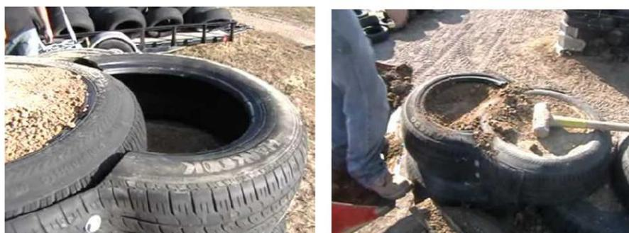
**Figura 2.14:** Representação da aplicação da técnica *half-tire* em obra (Earthship Biotecture 2016a)
