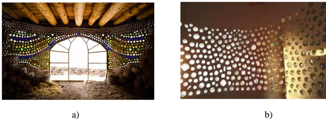
**Figura 2.19:** Parede constituída por garrafas de vidro de diferentes cores -a) (Earthship Biotecture 2017d); e de garrafas de vidro do mesmo tom -b) (Hippy 2015)
