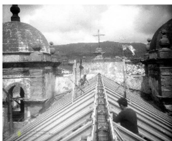
Fig. 14 – Substituição da estrutura da cobertura [19]
