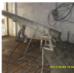
Fig. 5 – Adição de laje colaborante
