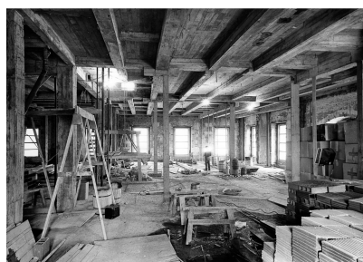
Fig. 15 – Substituição de pisos existentes [20]
