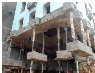
Fig. 13 – Inserção de estrutura subterrânea [18]
