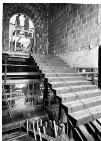
Fig. 12 – Inserção de caixa de escadas [17]
