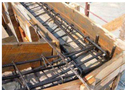
Fig. 10 – Inserção de viga cinto [16]
