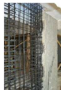
Fig. 16 – Substituição de paredes existentes [21]
