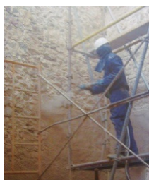
Fig. 4 – Projeção de reboco armado
