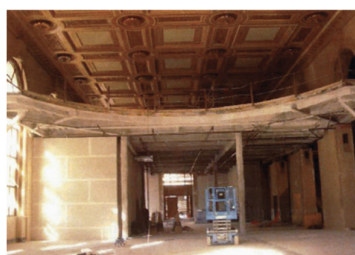
Fig. 7 – Adição de piso intermédio [13]
