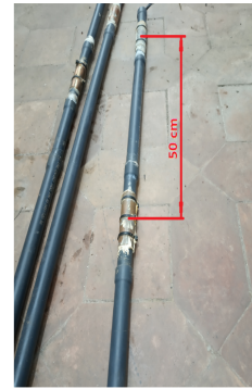
Fig. 3. Distribución de los sensores a lo largo del tubo de PVC en los primeros 3 metros
