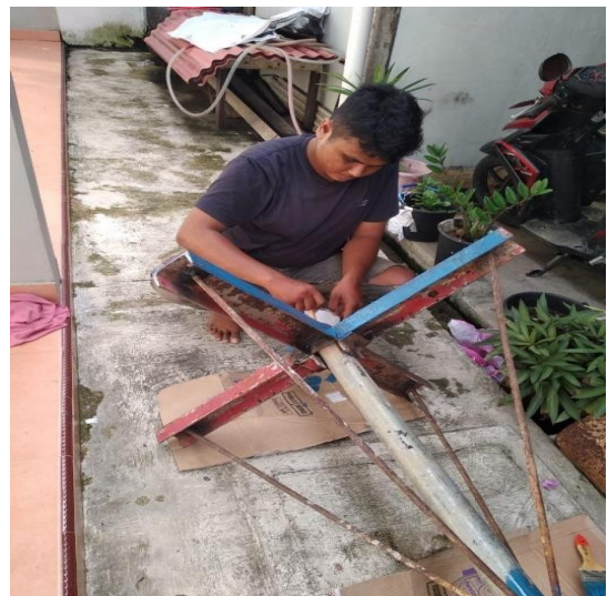
Gambar 3.2 Pembuatan Tiang Penyanggah
