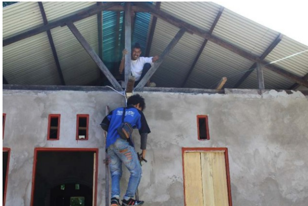
Gambar 5 Perbaikan Instalasi Listrik Rumah Warga
