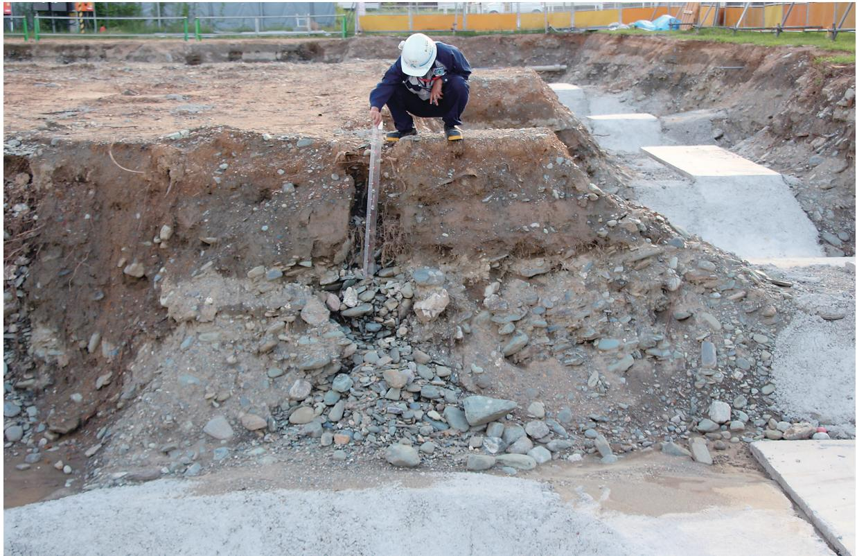
第9図 川田中小学校の校舎建替え工事現場のパイピング跡（撮影：川真田早苗）
