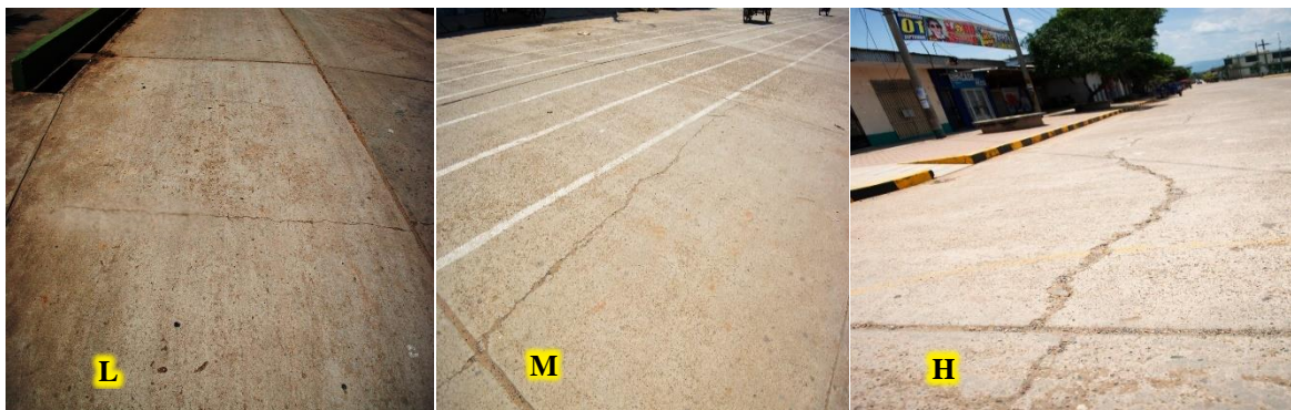
Figura 10. Daños de grieta lineal en sus tres tipos de severidad. (Fuente: Elaboración Propia - 2019).
