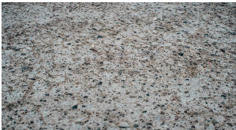
Figura 13. Daño de pulimento de agregados. (Fuente: Elaboración Propia - 2019).
