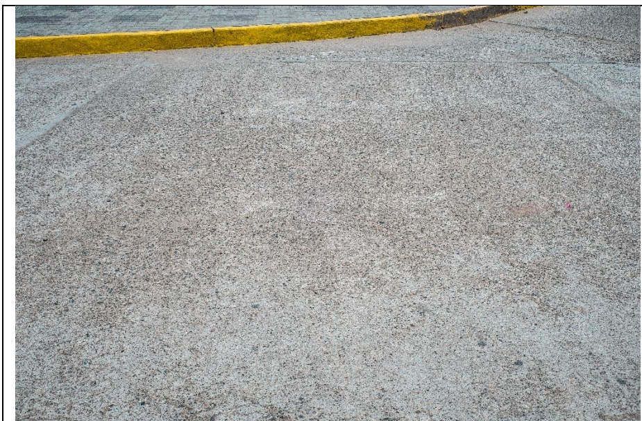
Foto 28: Daño de pulimento de agregados muy notables alrededor de las calles de la plaza provincial de Picota.
