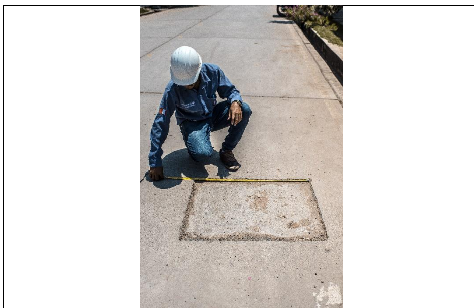
Foto 14: Realizando la medición del daño de parcheo grande en el Jr. Picota C-4 para evaluar su severidad.
