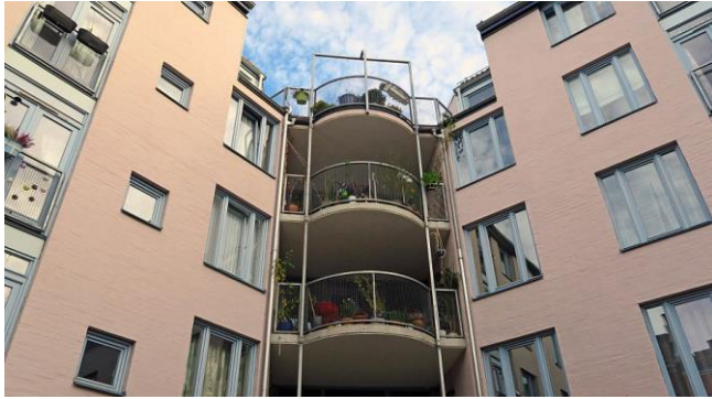
Figur 5: Fellesbalkongene i Friis gate 6, sett i fra bakgården (Stokland, 2018).
