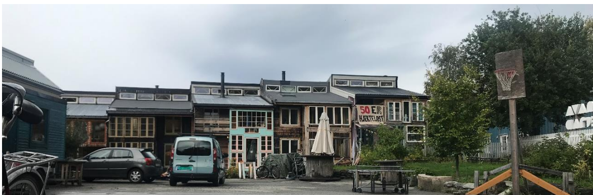
Figur 13: Rekkehus fra Svartlamon. Det er bygget med fokus på gjenbruk av materiale, og lavt ressursbruk (Århus, 2020).
