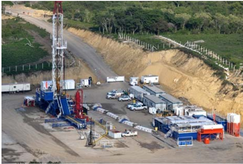
Figura V.15 Vista aérea de un pozo en construcción en Chicontepec
