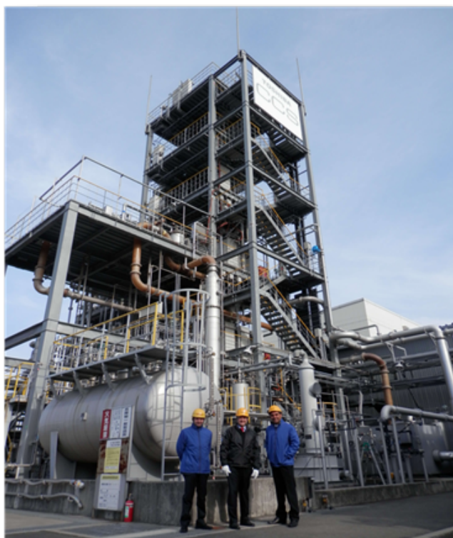
FOTO DE PORTADA: Planta piloto post-combustión de captura de CO 2 , desarrollada por la empresa Toshiba y ubicada en la carboeléctrica de Mikawa, al sur del Japón. Foto tomada el 19 de febrero del 2014. En la fotografía aparecen, de derecha a izquierda, el Dr. Carlos Serralde del Centro Mario Molina, un servidor y el Maestro César Contreras de la SENER.
