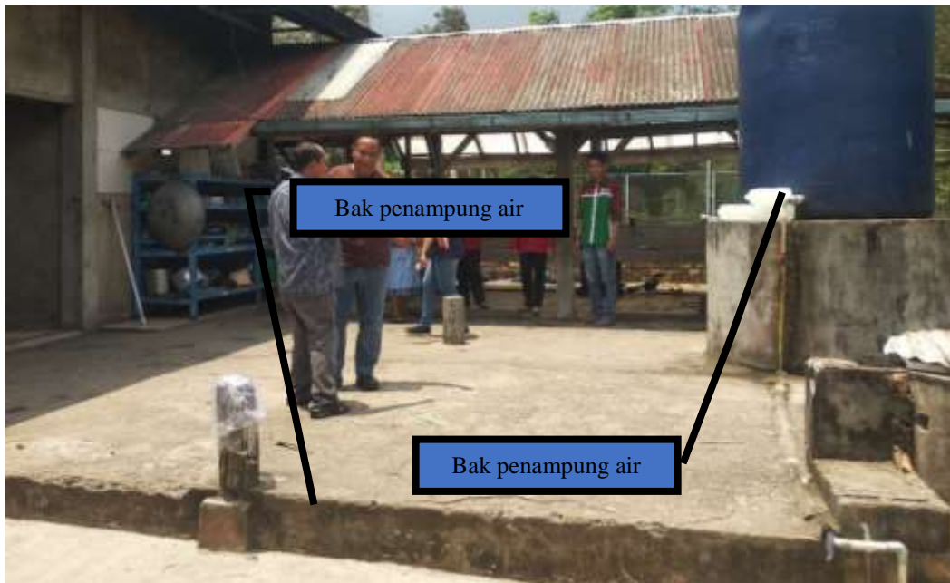
Gambar 2. Bak penampung air
