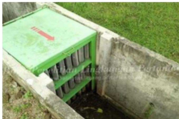
Gambar 3. FIO yang sudah terpasang di saluran irigasi (Sumber: Badan Litbang Pertanian 2019)
