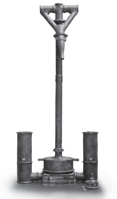
Imagen 3. Bomba hidráulica (o de Ctesibio) para minería, hallada en la Mina de Sotiel Coronada (Calañas, Huelva) 26 .
