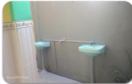
Gambar 5. Pembangunan fasilitas cuci tangan di SDN Karangkembang
