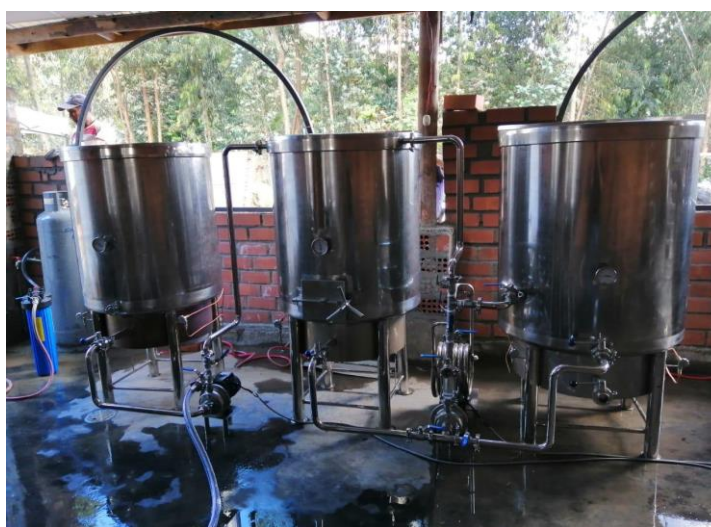
Figura 7.8. Línea de cocción con chaqueta sistema continuo (calentador, macerador y hervidor)
