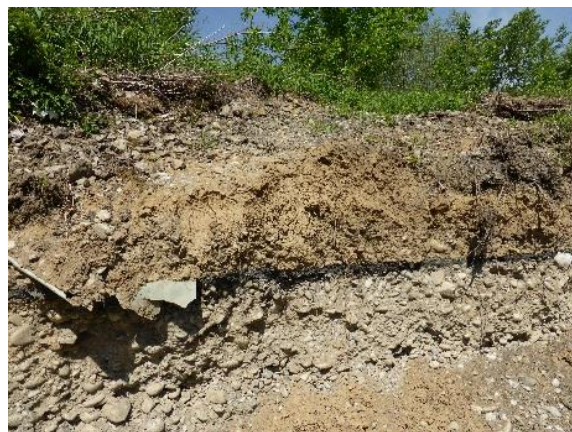
Obr. 3 Zasypaná vrstva odpadového troskového materiálu. Dubnica nad Váhom.
