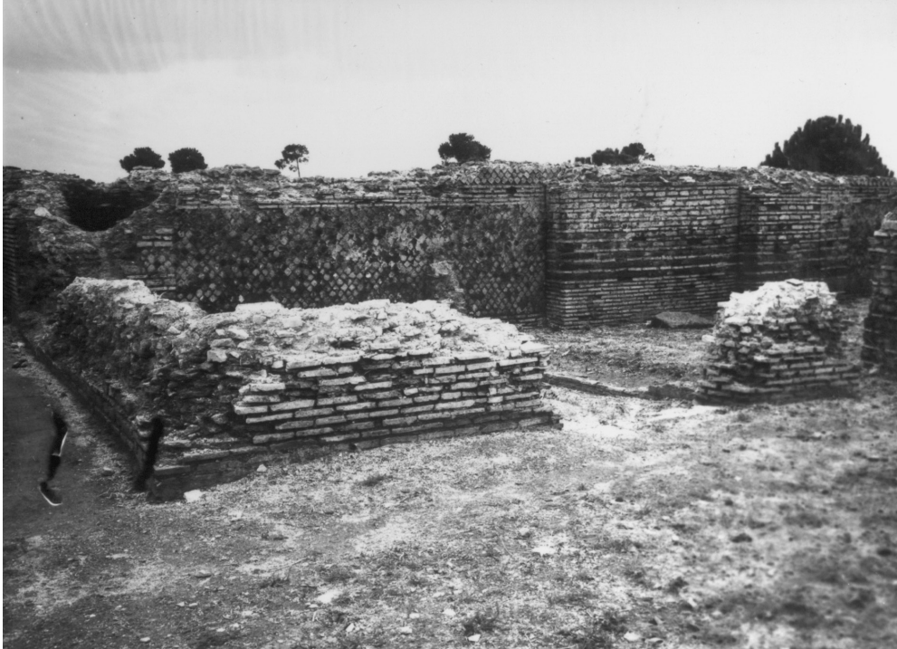
Fig. 5.69 – Caseggiato IV ii 7, hall 06-07, north-western corner prior to restoration (Scavi di Ostia, Archivio Fotografico, ref. 1768)
