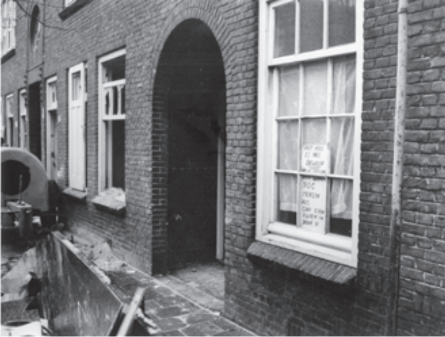
Afb. 10.3 Straat in de Schilderswijk met veel onbewoonde woningen, waarvan de jeugd al een voorschot heeft genomen op de aanstaande sloop. Op het plakkaat achter het raam staat: 'Dit huis is nog bewoond. Dus gooi geen ruiten in. Dank u'. In een dergelijke omgeving had het weinig zin meer de stoepjes te vegen. De schoonmaakknormen binnenshuis, inclusief het belang van schone, gewassen gordijnen, bleven echter bestaan. Particuliere collectie John Van Vliet, ongedateerd.
