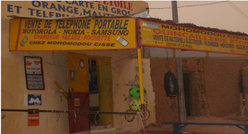
Photo 3.10 La façade de l'un des premiers commerces de téléphone portable à Kidal, août 2009 (cliché Naffet Keita).
