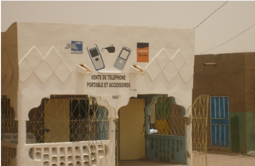
Photo 3.11 Façade d'un nouveau commerce de téléphone portable à Kidal, août 2009 (cliché Naffet Keita).
