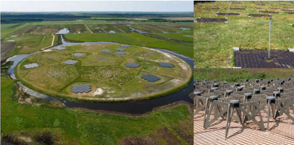
Figuur 2: De LOFAR kern (de 'superterp') nabij Exloo (Drenthe), met daarop verschillende stations met HBA en LBA antennes ( links ). Individuele LBA ( boven rechts ) and HBA ( onder rechts ) antennes. (LOFAR/ASTRON).
