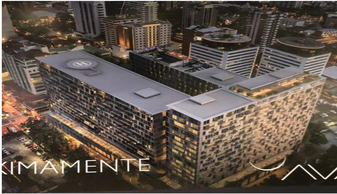
Figura 3. Vista general del edificio
