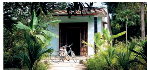
Viviendas resilientes a las inundaciones, Vietnam – Chris Goldberg
