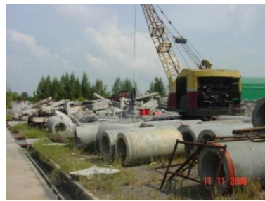
รูปที่ 2 พื้นที่ทิ้งหัวเสาเข็ม
