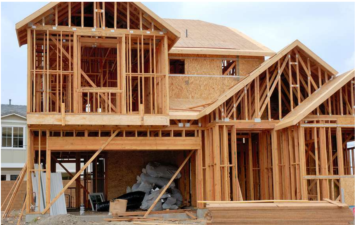
Figura 12 – Construção residencial em Wood-frame.
