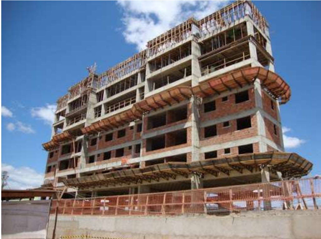
Figura 4 - Sistema construtivo convencional em concreto armado.
