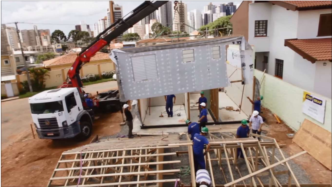
Figura 13 – Içamento e posicionamento de uma parede em uma construção TECVERDE.
