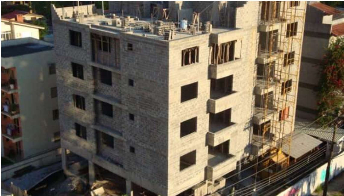
Figura 5 - Construção em alvenaria estrutural.
