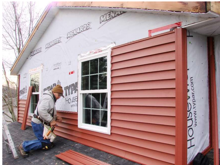
Figura 20 – Siding aplicado à fachada externa.
