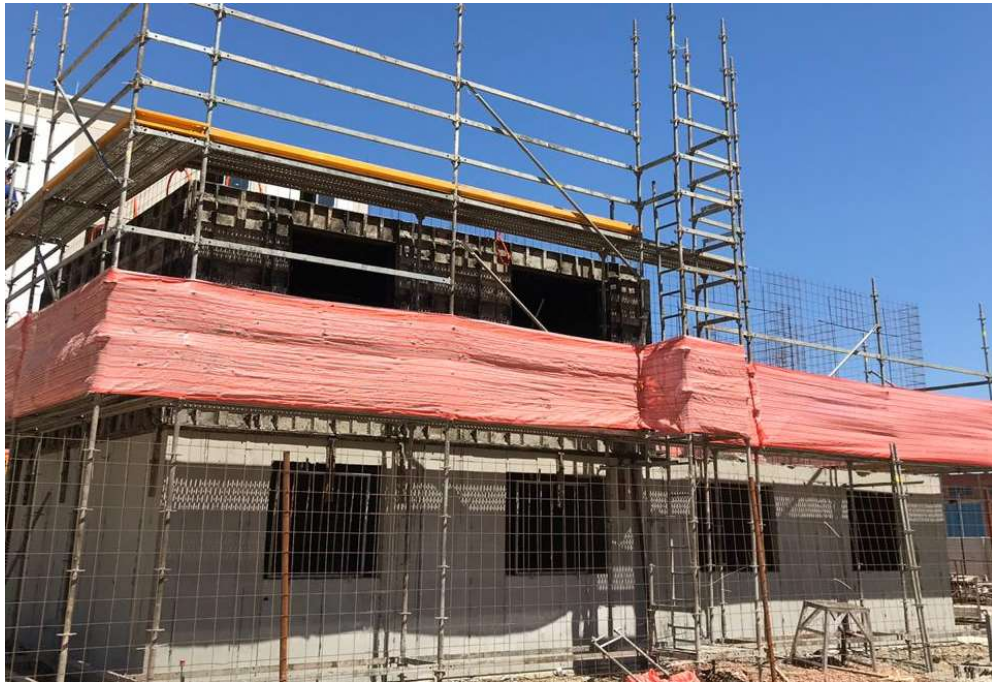
Figura 7 - Habitação em Parede de concreto
